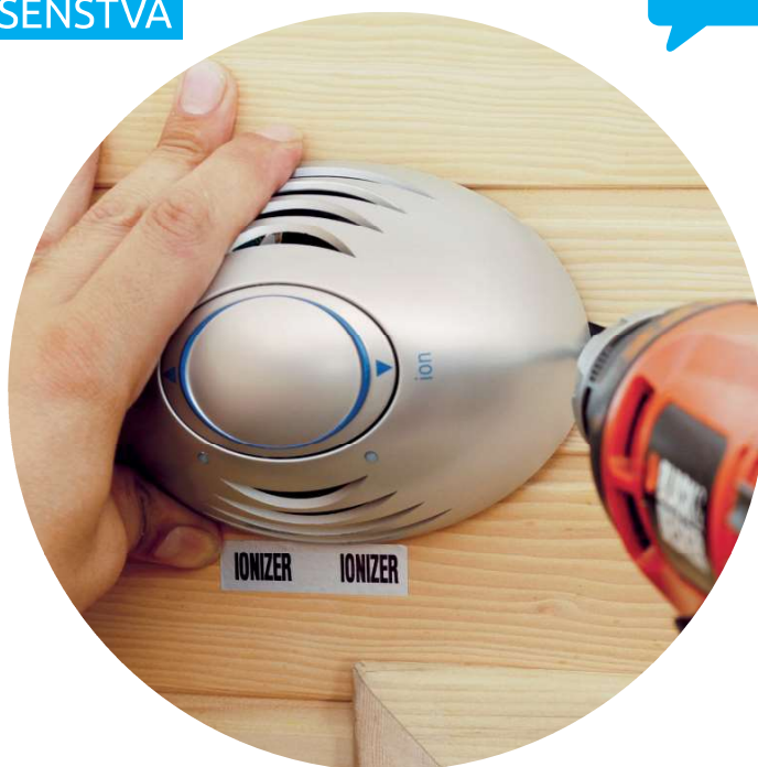
Instalace ionizátoru
